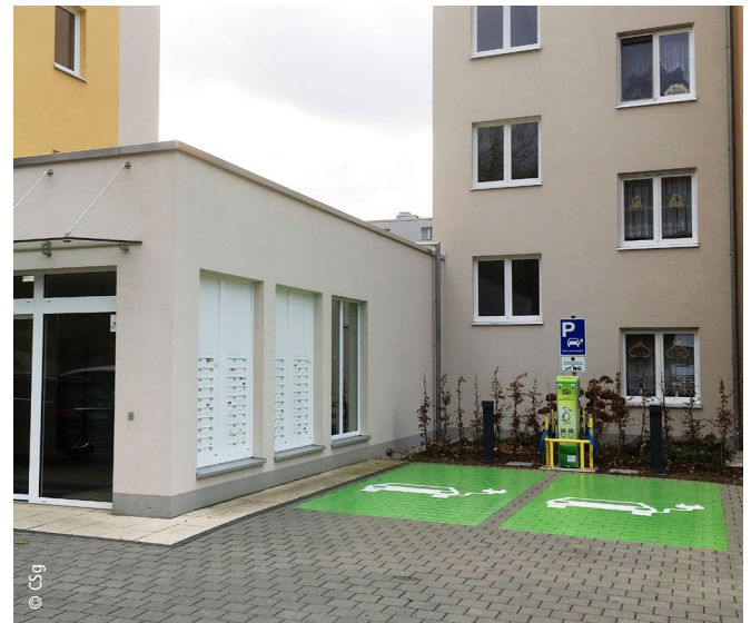
Abb. 4: Ladestation Eislebener Straße 11
