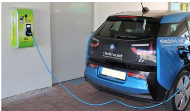
Abb. 6: öffentlich zugängliche Wand-Ladestation am Geschäftsgebäude der CSg
